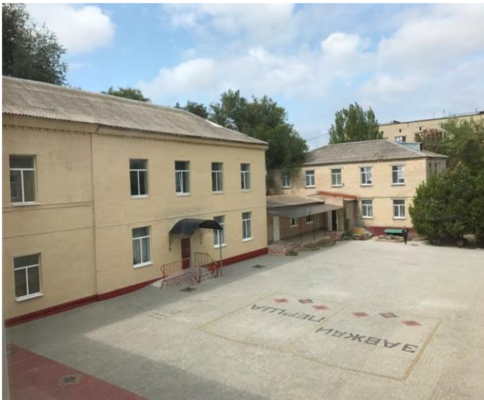
КЗ «Василівська ЗОШ № 1» капітальний ремонт подвір'я та фасаду
