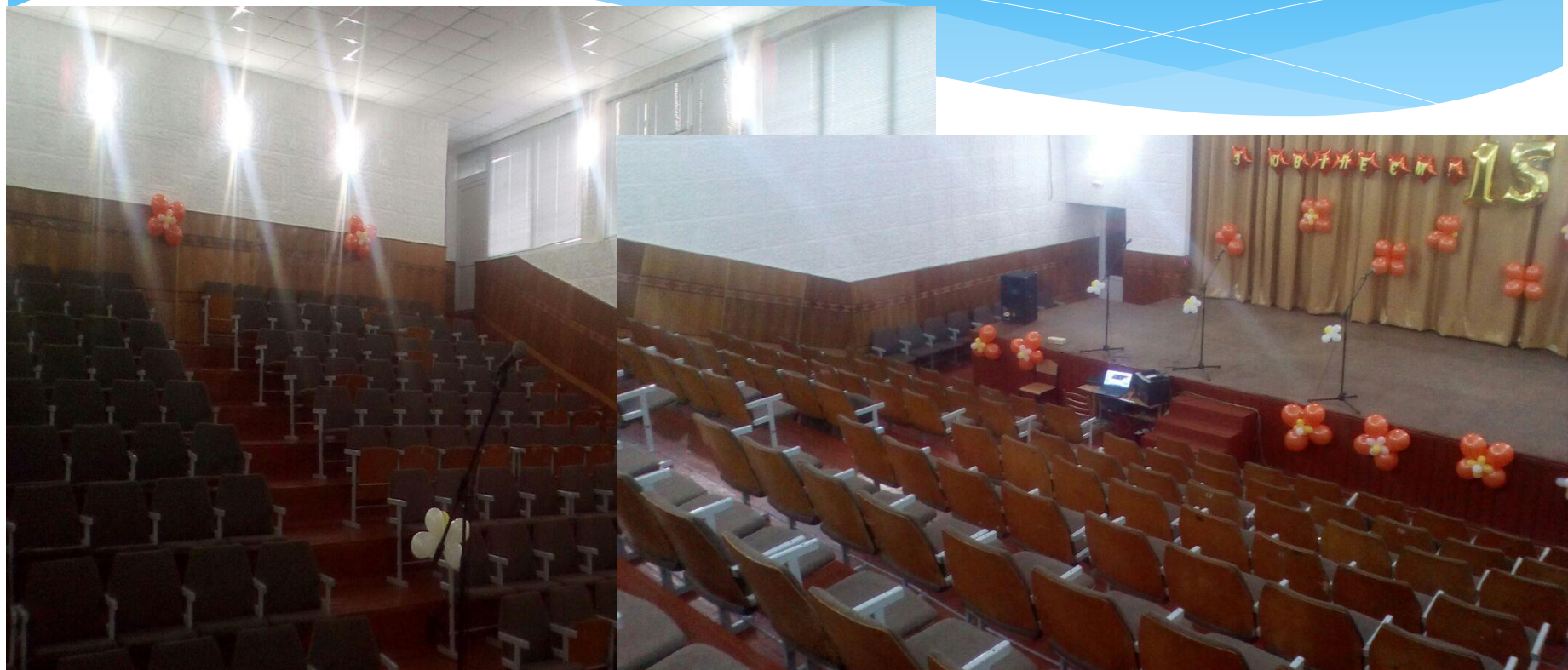
КЗ «Василівська гімназія «Сузір'я» поточний ремонт актового залу
