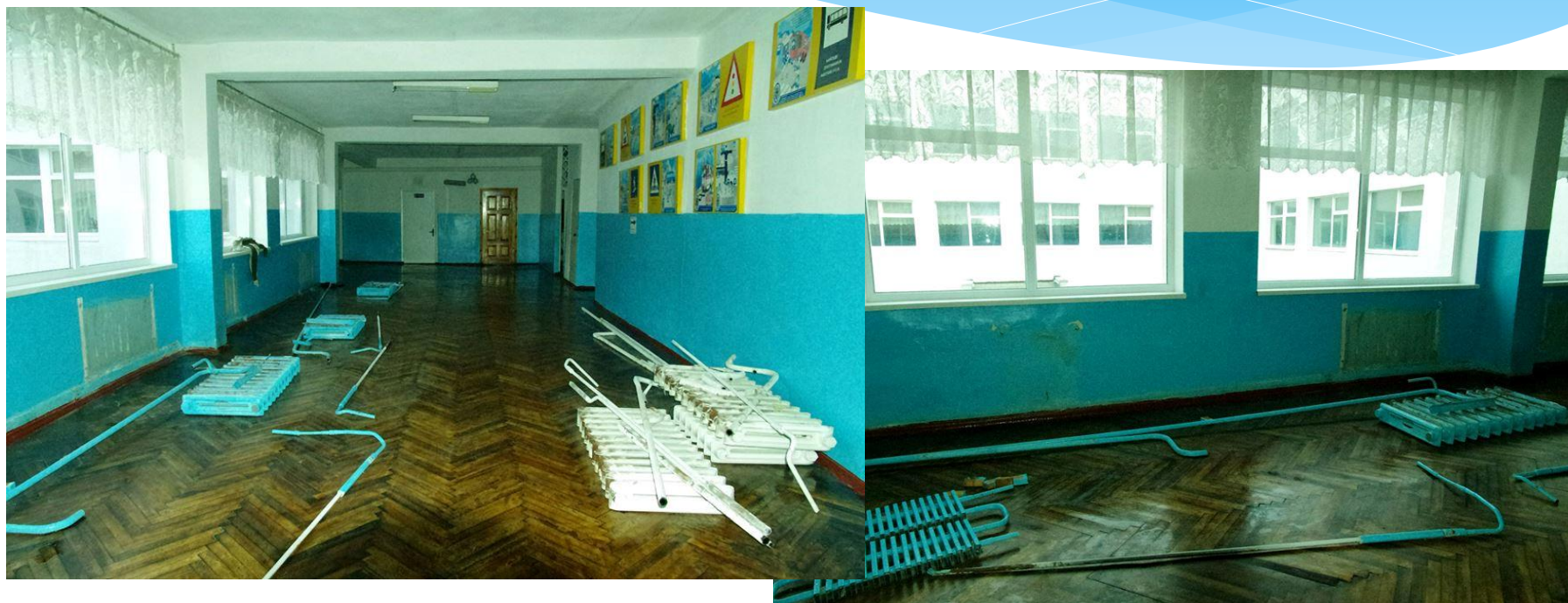
КЗ «Степногірська ЗОШ «Капітальний ремонт системи опалення
